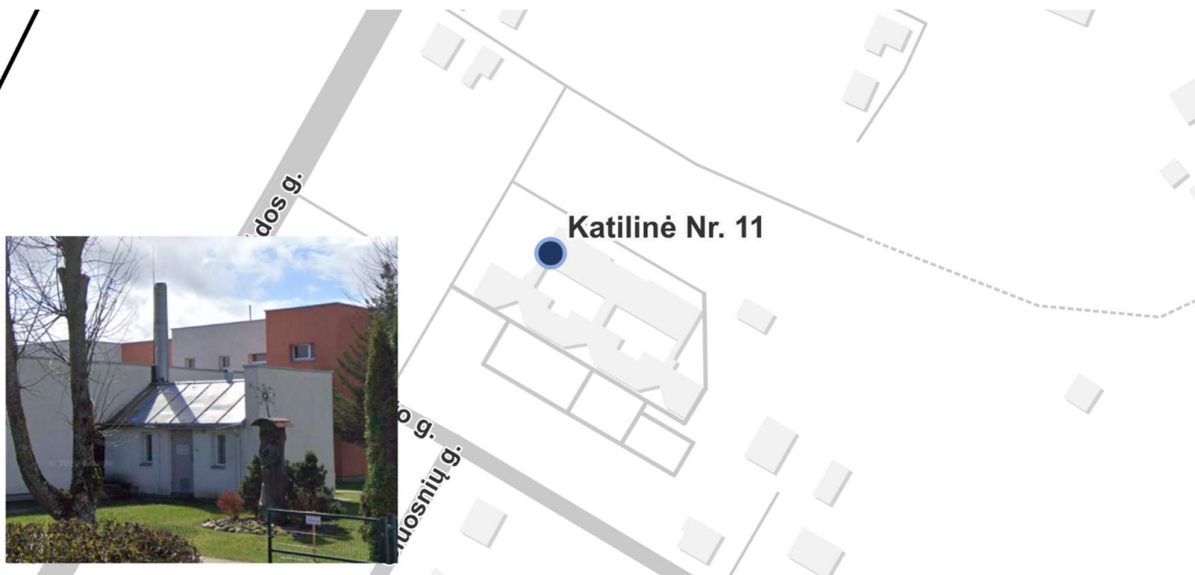
52 pav. Katilinė Nr. 11 ir šiluma aprūpinami pastatai
